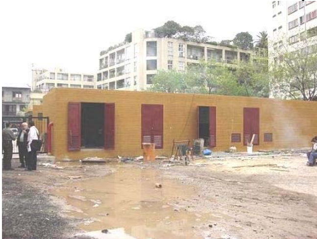
FOTO 7 / OBRA CIVIL CON SUS 4 SALAS Y DETRÁS EL TANQUE DE RESERVA.
