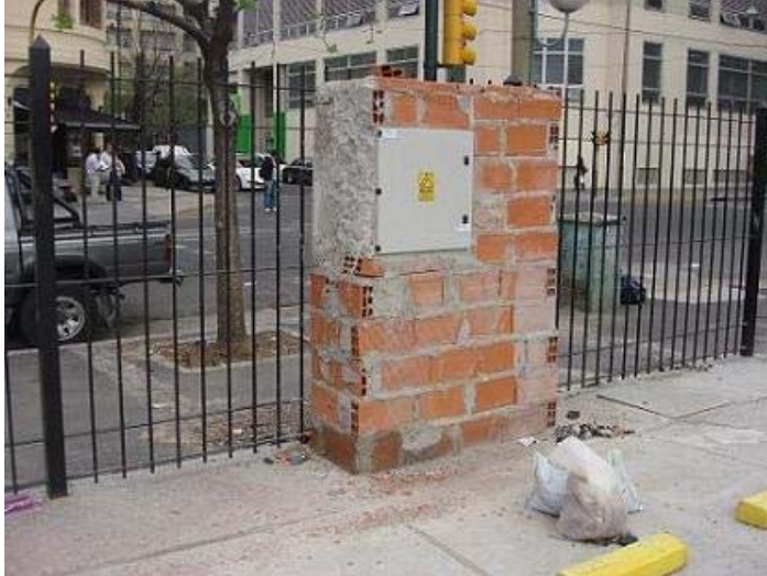
FOTO 12 / DESDE ESTA CÁMARA NUEVA SE LLEVA LA TRIFÁSICA AL TABLERO DE CONTROL.
