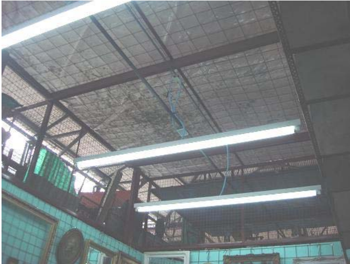
FOTO 4 / MALLA CUBIERTA CON TELAS.
