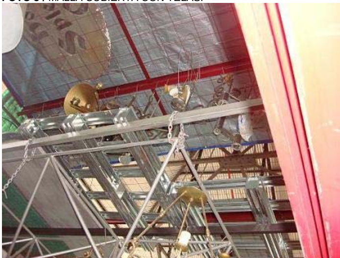
FOTO 5 / MALLA CUBIERTA CON TELAS.
