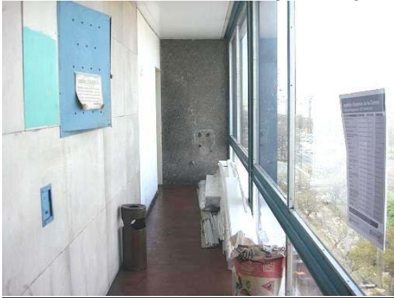
FOTO 1 / Baño Hombres 7° piso ala Perón: Pasillo a baño de caballeros obstruido con materiales de construcción.
