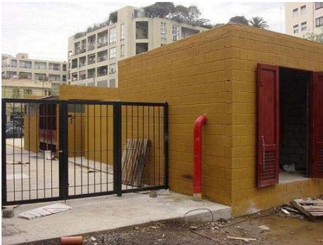
FOTO 8 / ENTRADA DE LA SALA DE BOMBAS.
