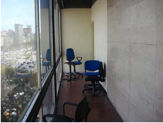
FOTO 7 / Baño Hombres 3° piso ala Sarmiento: Pasillo obstruido con sillas. Baño cerrado con llave.
